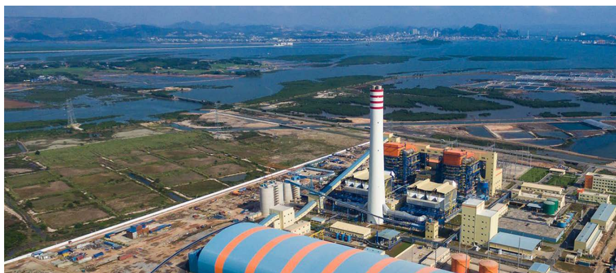
Thang Long thermal power plant. (Image: VietnamNet)
